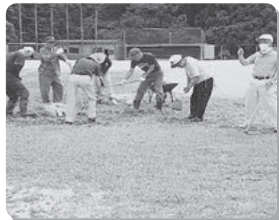
島根スポーツ広場整地作業
